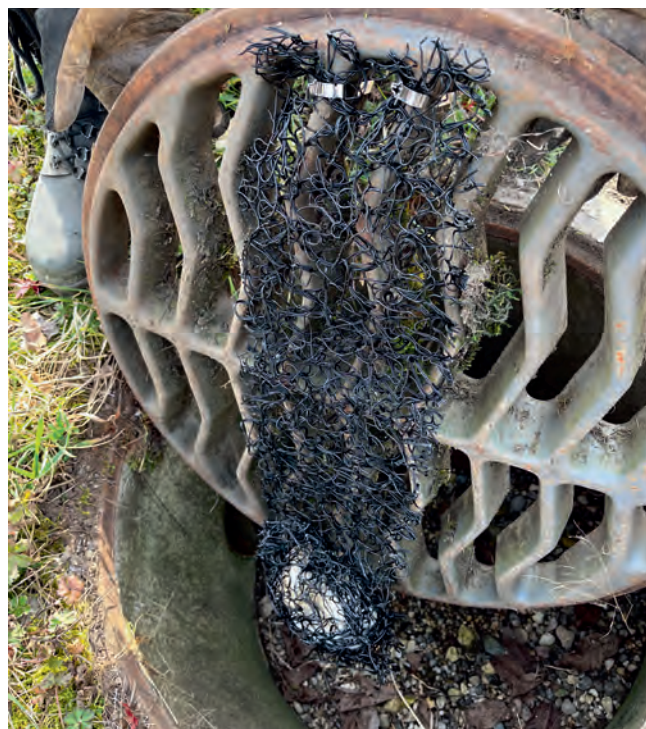
Die Ausstiegshilfe ist am Dohlendeckel montiert.
