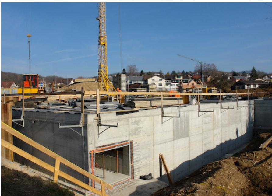
Das Regenbecken im Gebiet Ziegelmatte im Rohbau, Foto: Willi Baldinger
