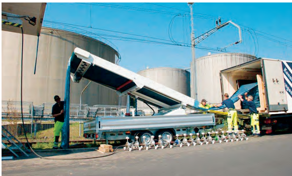
Einzug eines Inliners (Innenschlauch) zwecks Kanalisationsreparatur
