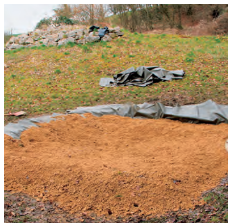
Teichfolie mit Mergelschicht
