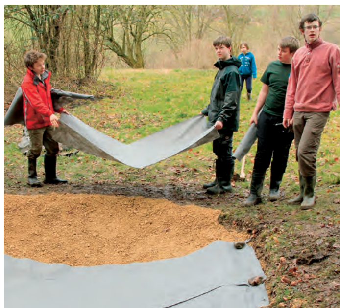
Das Teichvlies wird auf die Mergelunterlage gelegt.
