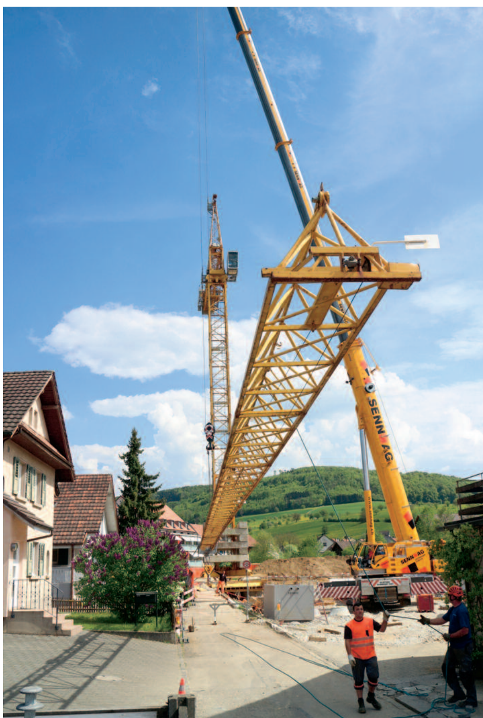
Mit viel Know-How und Fingerspitzengefühl: der Kran wird aufgebaut.
