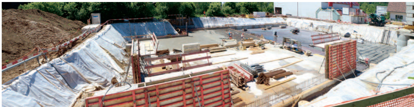
Das A und O des Bauhandwerks: ein gutes Fundament – Betonarbeiten Bodenplatte.
