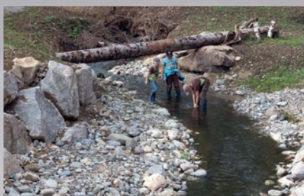
Der querliegende Baumstamm ist keine Mutprobe, sondern soll Schwemmholtz zurückhalten.
