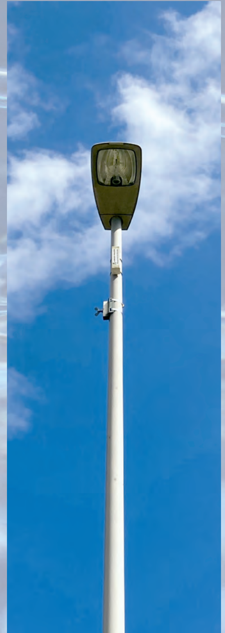
Datenempfänger an einer Strassenlaterne
