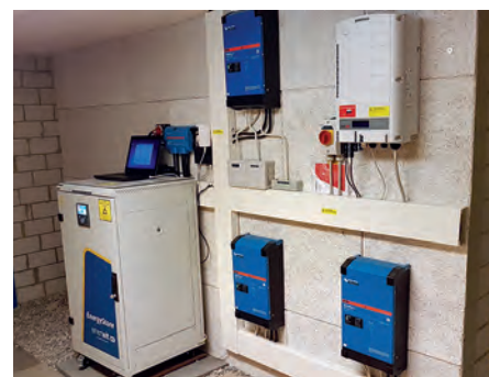
Elektrische Installation der PV Anlage mit Batteriespeicher (in Kühlschrankgrösse)
